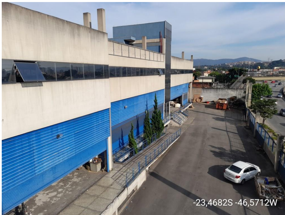
VISTA DA FACHADA PELA SACADA DO 2º PAVIMENTO
