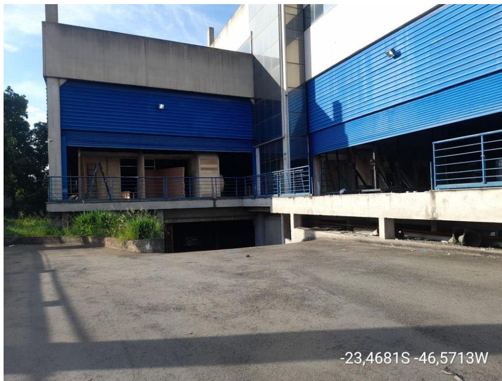
ACESSO A GARAGEM SUBSOLO
