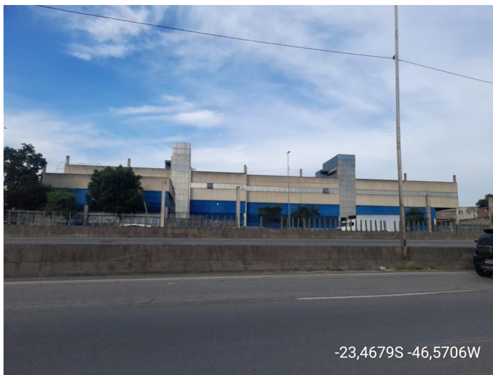
FACHADA FRONTAL DO IMÓVEL AVALIADO
