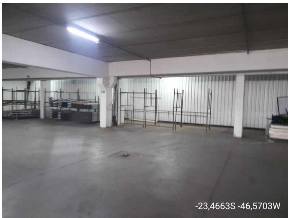
VISTA GARAGEM SUBSOLO
